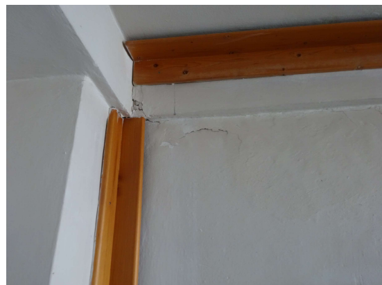
Objekt A – škola - Detail trhliny u sloupu
