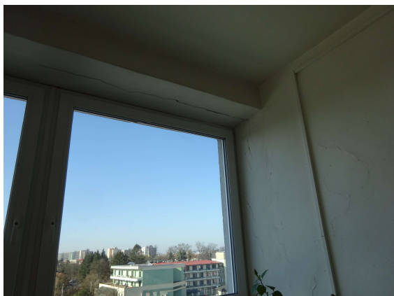
Objekt A – škola - trhliny v západní štitové stěně budovy školy
